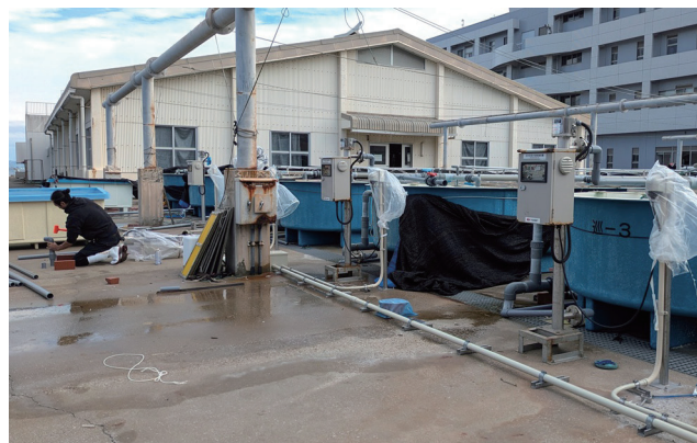
職員による配管取付作業
